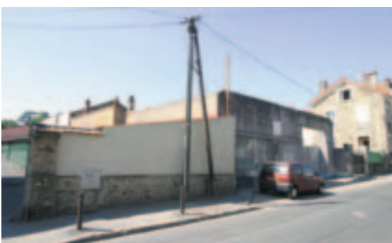
Ici, futur parking côté rue de Paris
